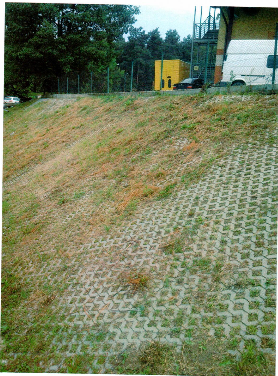
Widok skarpy od strony południowej
