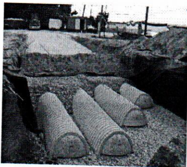
Fot. 5. Montaż komór drenazowych StormTech (materiały informacyjne Ekobudex)
