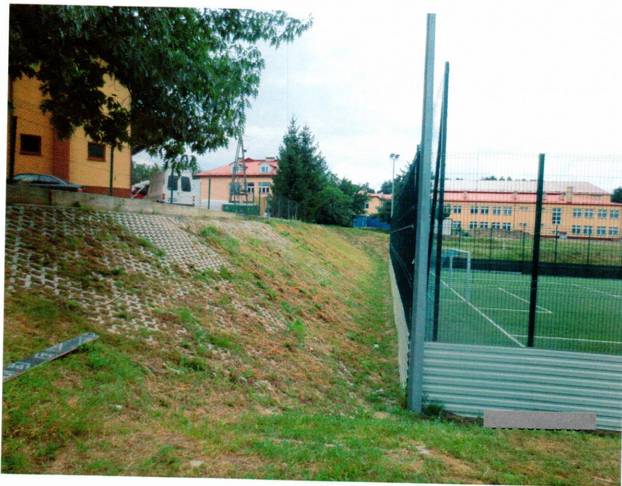
Widok skarpy od strony północnej
